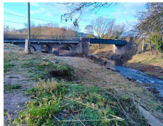
Pont de la RD 14 –Pierrefeu du var
