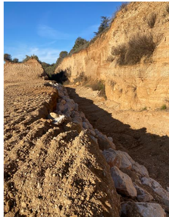
Février 2023: travaux d'urgence réalisés par la SOMECA
